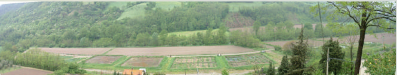
impianto di fitodepurazione a servizio del Comune di Dicomano - Firenze (3500 ae)
