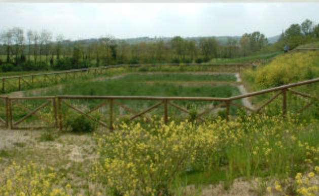
impianto di fitodepurazione a servizio della frazione di Toscanella, Comune di Dozza (120 ae)
