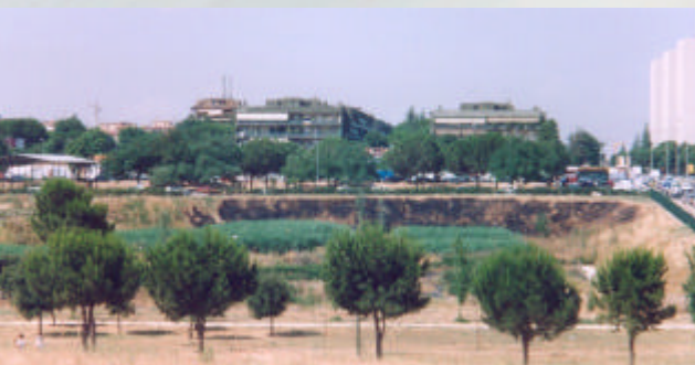
impianto di fitodepurazione a servizio del quartiere di Torbellamonaca, Roma (1000 ae)
